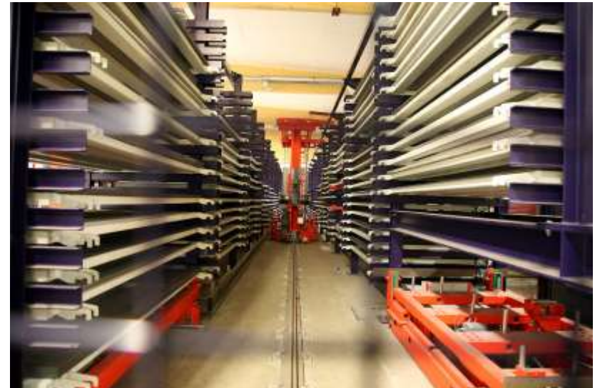
Ein vollautomatisches Lagersystem mit einer Kapazität von 1.200 t versorgt die Laseranlagen.
